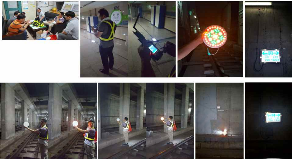
그림 4.7 덕천 ~ 수정 터널구간 LoRa 통달 시험모습
