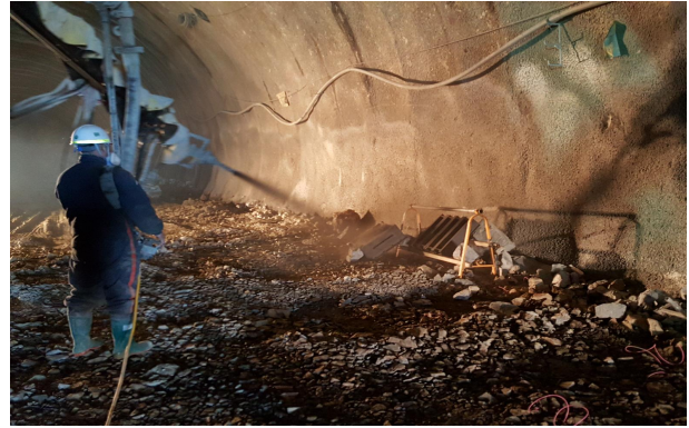
그림 3.4 슛크리트 시험타설 전경
