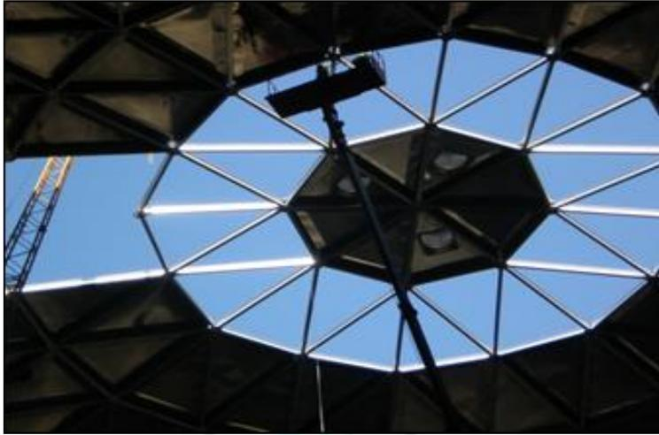
그림 10. 1, 2번 Ring 설치
