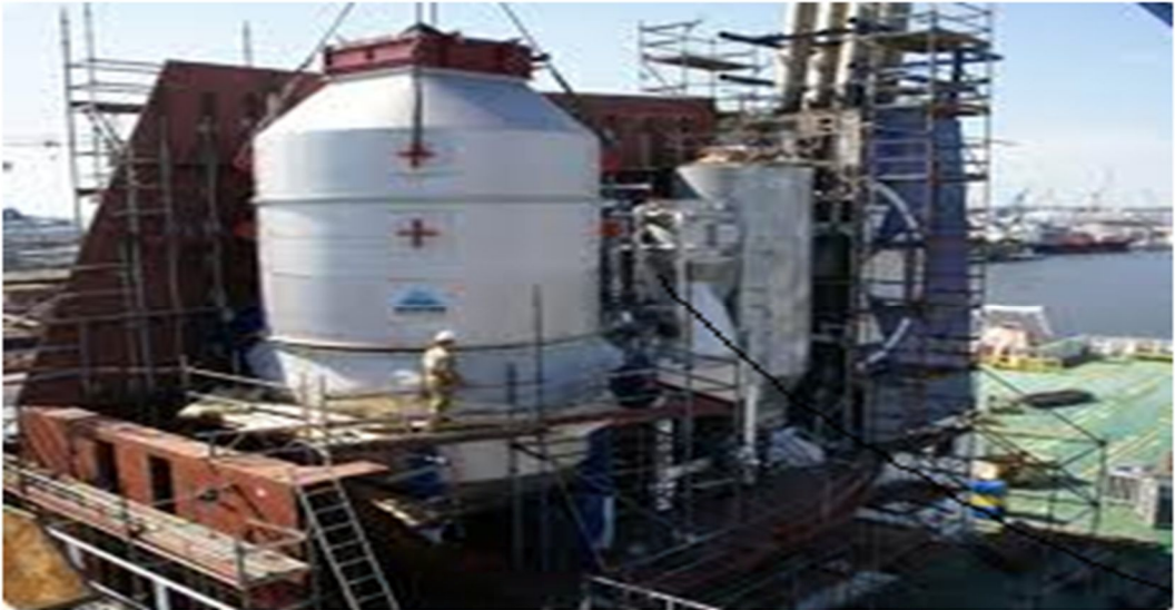
<그림 24>. < Scrubber 를 장착하는 모습>
