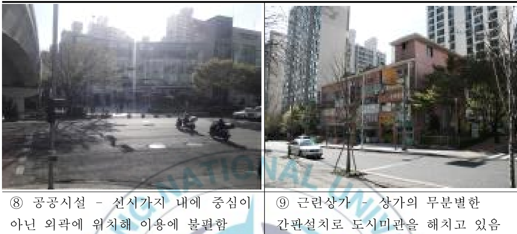
그림 4.7 공공시설 및 가로변 건축물 현황
