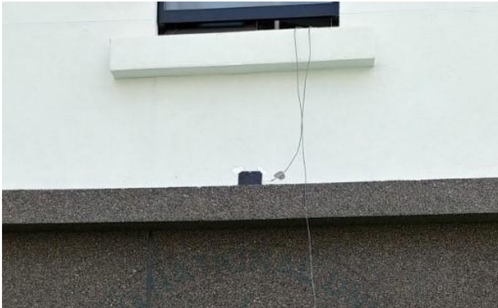
그림 2.6 열교 부위 열류 센서 설치 상태
