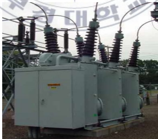
그림. 2 115kV 유입회로차단기
