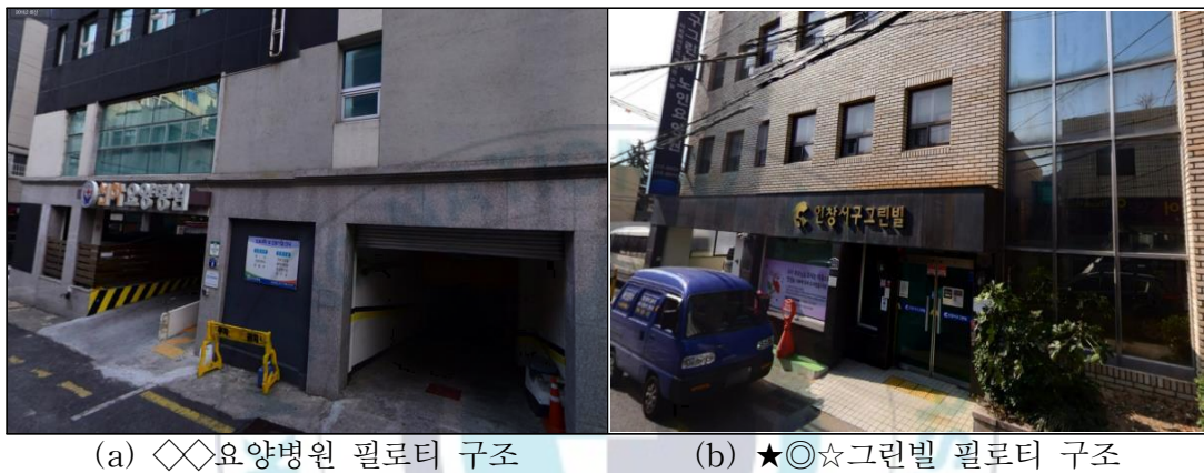
<그림 3-1> 요양병원 및 노인요양시설의 필로티 구조
