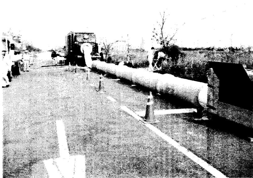
그림 4.4 초기균열 발생된 관에 대하여 관 내부의 라이닝으로 보수 처리하는 과정
