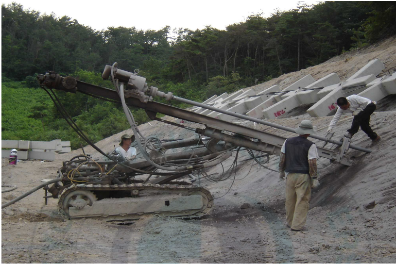
그림 3.11 천공 작업 전경
