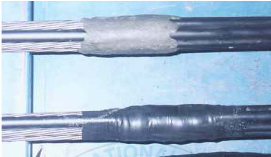
그림 3.9 자유장 부위 에폭시 방수 작업 전경
