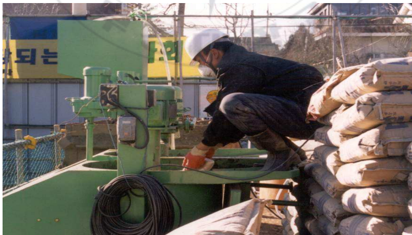
그림 3.12 그라우팅 작업 전경
