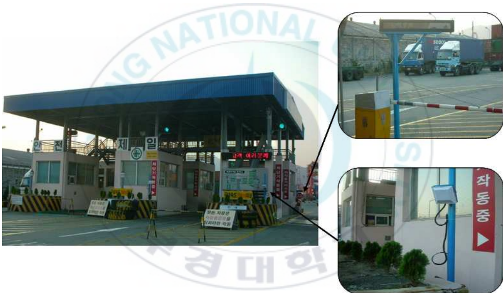
[그림 3-3] RFID시스템이 설치된 컨테이너 터미널 게이트
