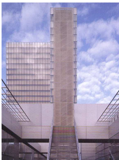
그림 15 도미니크 페로, 파리 국립도서관, architects & design 도미니크 페로, CA
