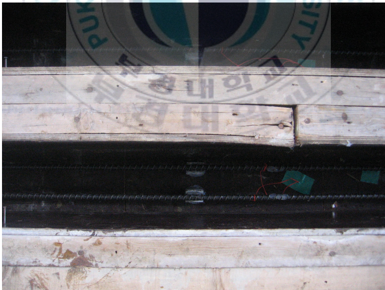
< 사진 3-2 > CFRP bar 배근 과정
