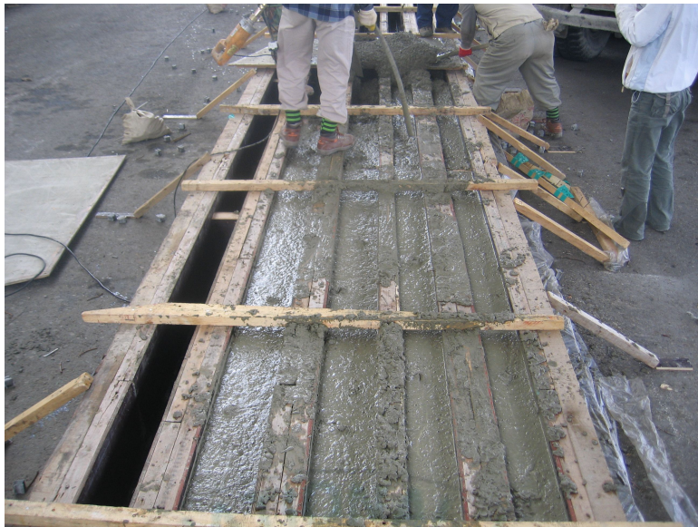
< 사진 3-3 > 콘크리트 타설 과정
