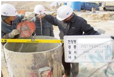
3) Casing 근입, 심도/수직도 확인
