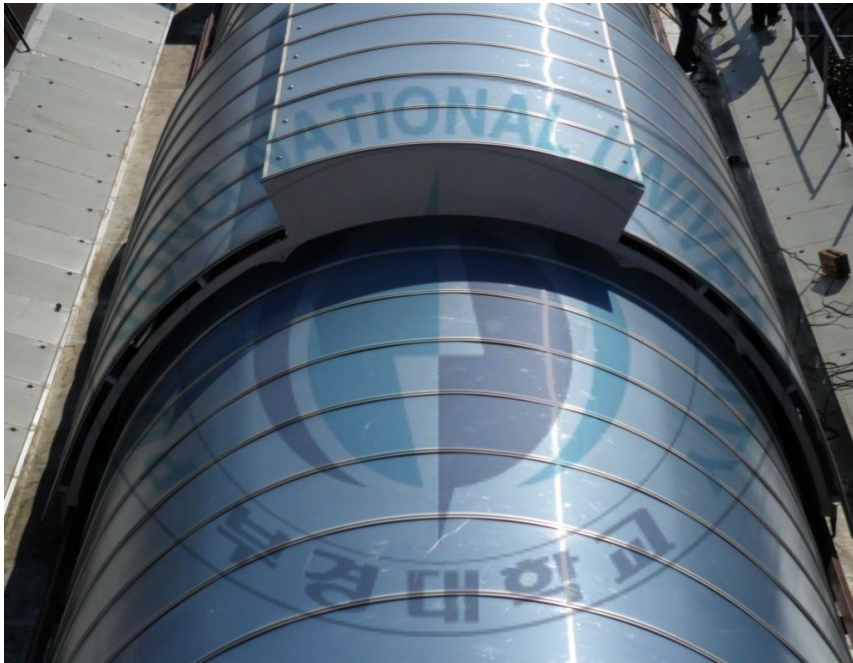
Fig. 12 부산 부평시장 환기구 및 지붕 (3)
