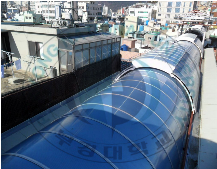
Fig. 13 부산 부평시장 환기구 및 지붕 (4)
